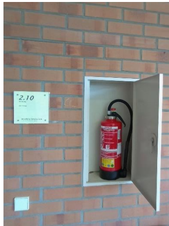
Abbildung 5 - Wandnischen mit Handfeuerlöscher
