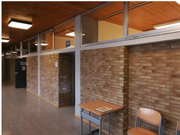
Abbildung 11 - Typische Flurwand (Quelle: Leimbach und Bartels Architekten)
